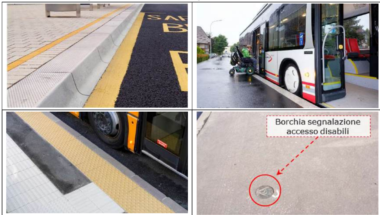
Fig. 66 – Cordolo sagomato per accosto ottimale dei mezzi del TPL, esempi di percorsi tattili e di pensiline accessibili alle persone a mobilità ridotta
